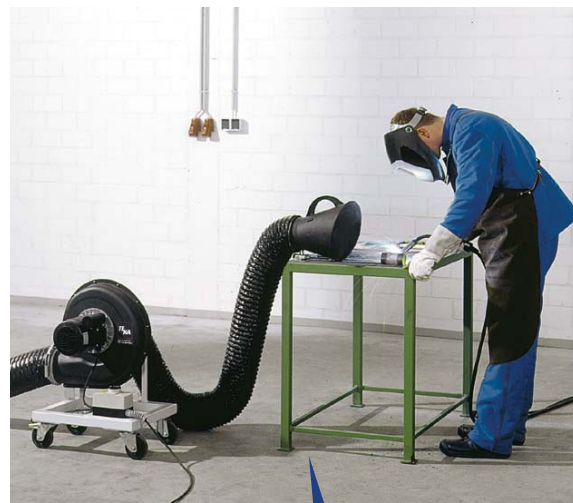
Exemple d'application : Ventilateur mobile
