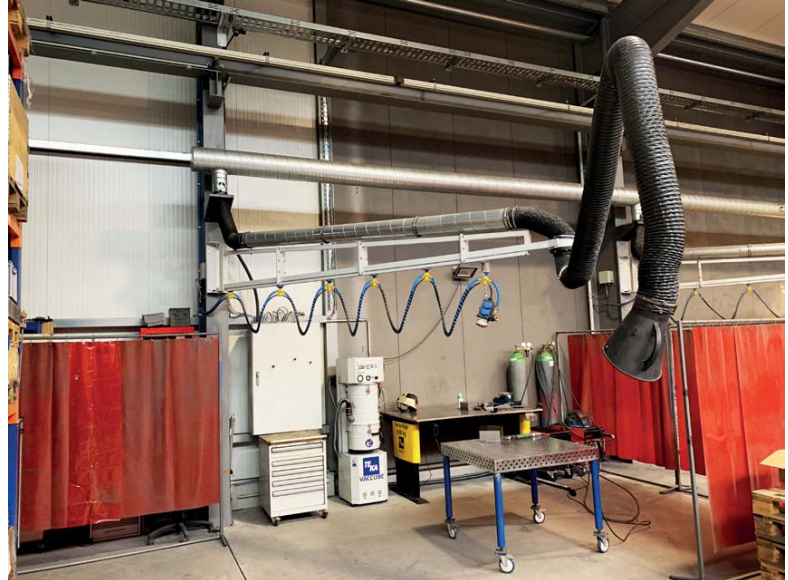
Absaugarm mit Wandausleger und Führungsschiene
