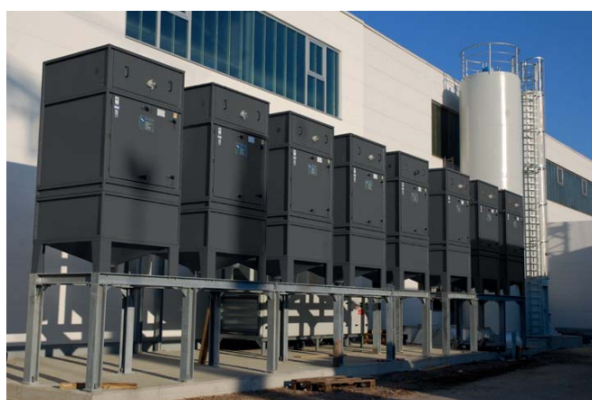
ZPF mit nebenstehendem Ventilator im Schalldämmgehäuse
