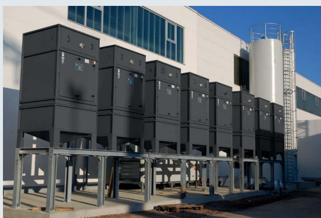
ZPF avec ventilateur à côté en boîtier insonorisant
